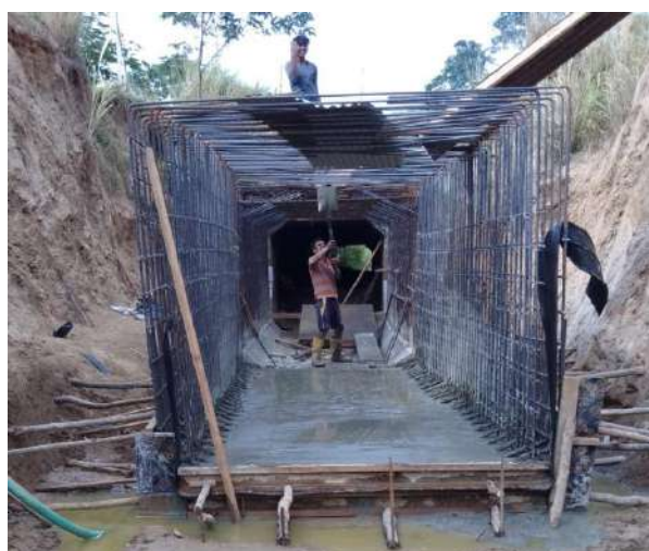
Conduit Structure
